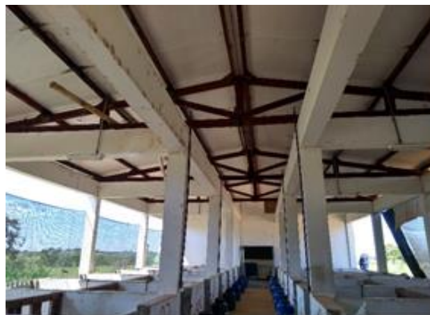
Figura 1 - Vista frontal do galpão
